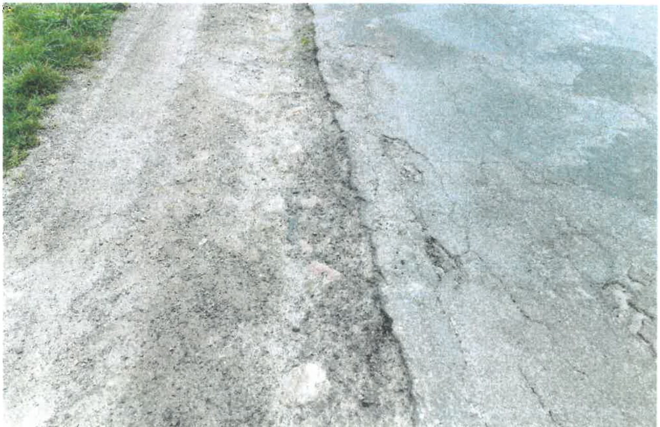
Foto 2: Im Randbereich zum Sommerweg ist Pflaster erkennbar
