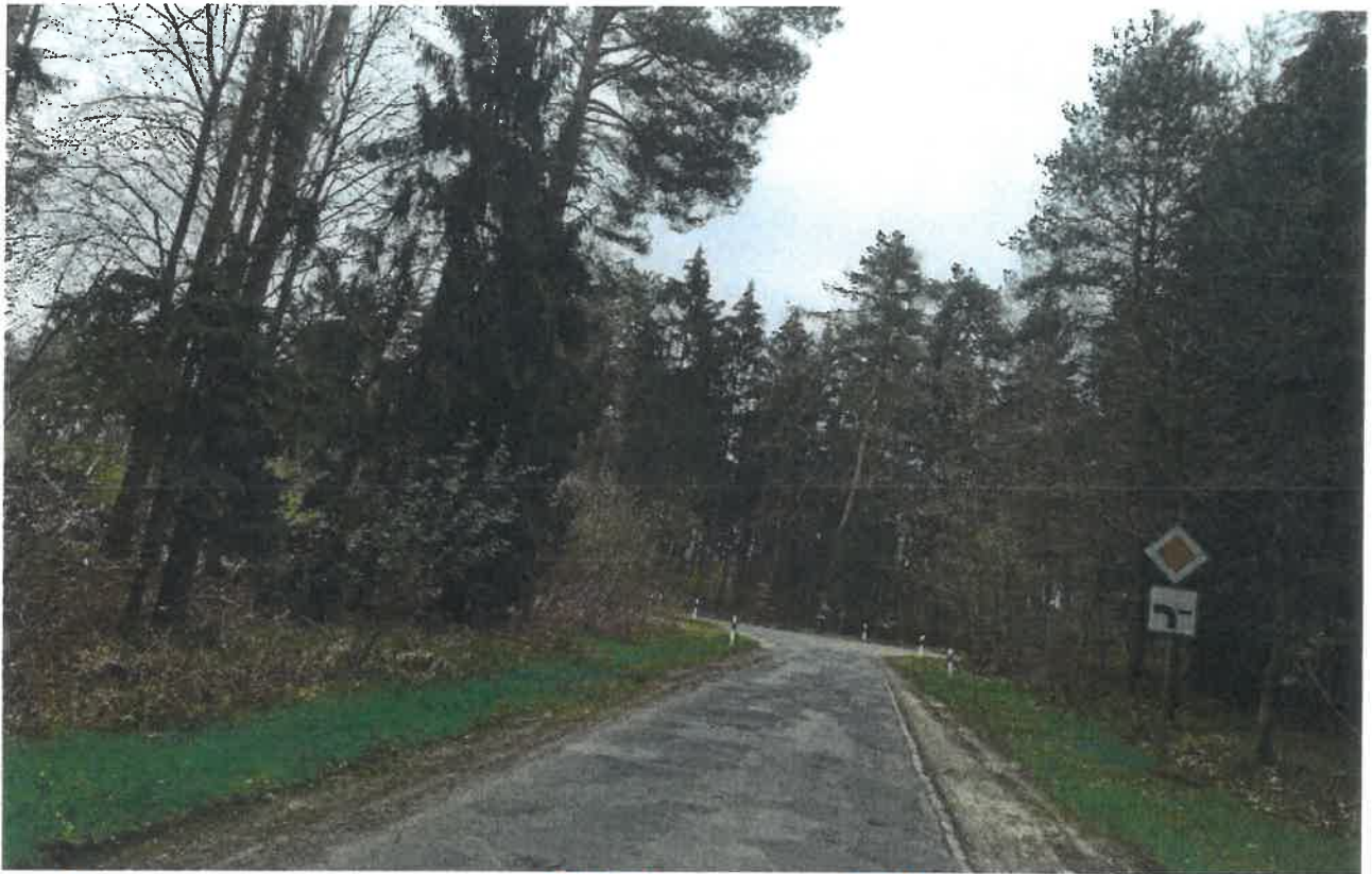
Foto 3: Im Bereich des Waldstückes ist die Fahrbahn im Betonbord gefaßt.
