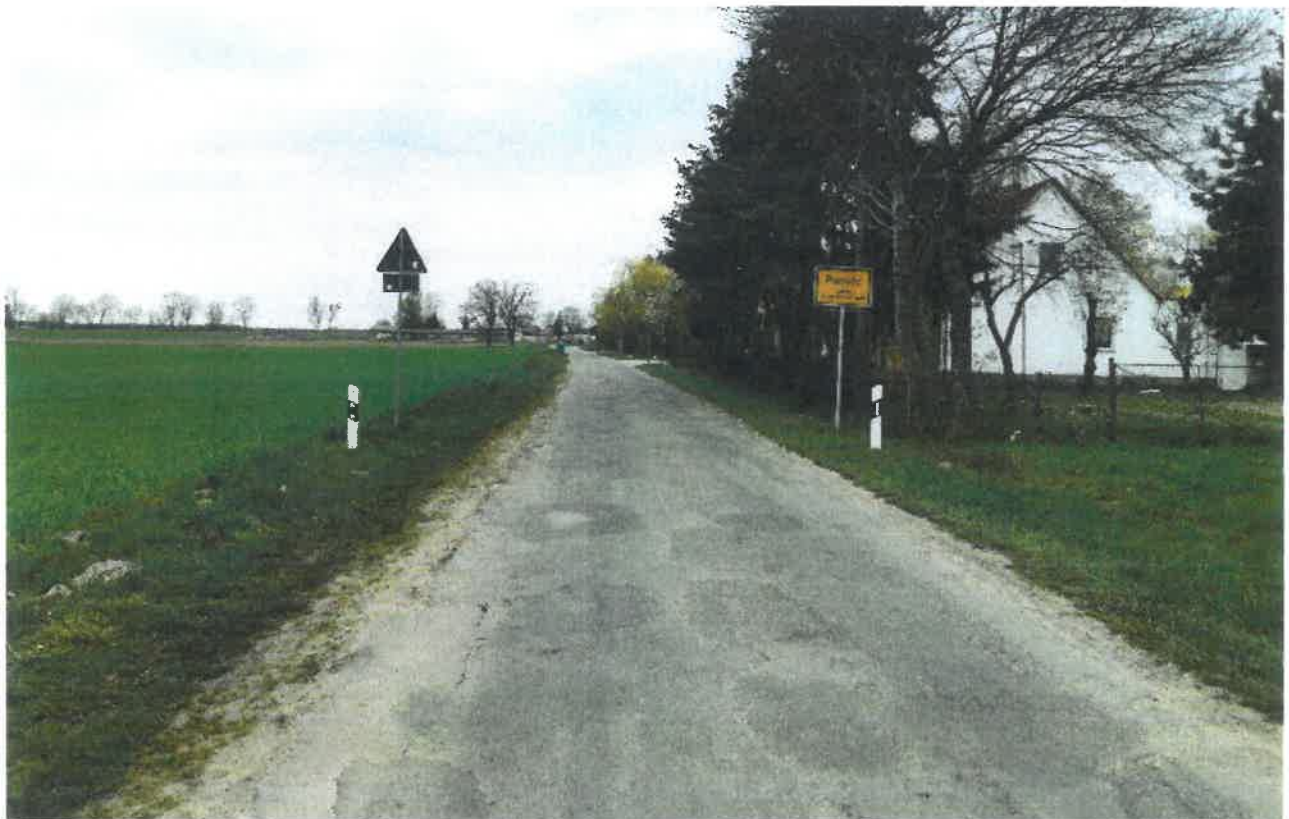
Foto 6: Ortseingang Pamitz. Auch hier sind Flickungen und vereinzelte Risse erkennbar.
